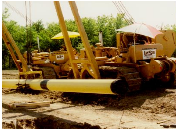
Tendido de gasoductos de transporte
