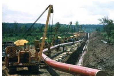
Tendido de gasoductos de transporte
